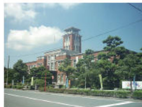
▲昭和8年に戸畑市役所として完成した歴史ある建物。
